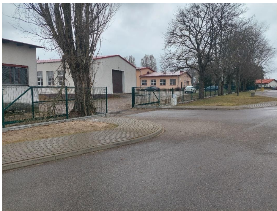
Fot. Starostwo Powiatowe w Pieszce Wykonanie części ogrodzenia przy warsztatach szkolnych
