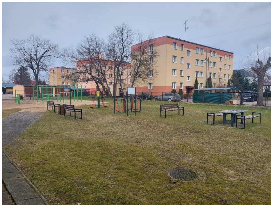
Fot. Starostwo Powiatowe w Pieszce Budowa siłowni zewnętrznej wraz z zagospodarowaniem terenu przy I Liceum Ogólnokształcącym w Pieszce
